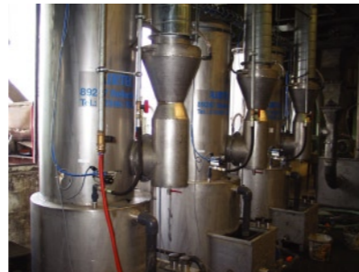
Edelstahl-Venturi-Nassabscheider zum Absaugen klebriger und brennbarer Stäube
